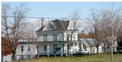
9. Une résidence sur la route 132, à l'ouest du site
