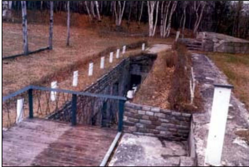
Photo 52 Le fort d'en bas avant sa destruction partielle (photo 1991, collection : GIRAM)
