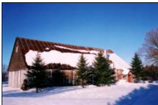
Photo 58 L'ancienne grange avec étable en bois cordé, propriété de la SPIPQS, pourrait accueillir pour fin d'interprétation des instruments agricoles typiques de la première partie du 20 e siècle (coll. : GIRAM)
