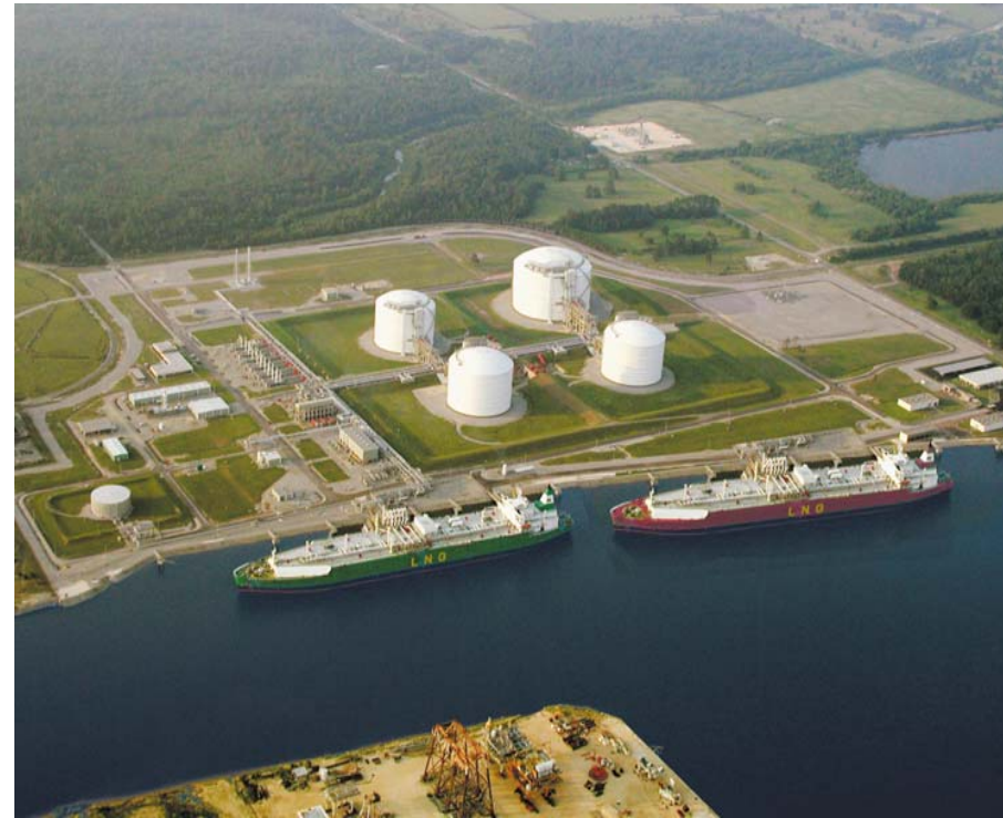
Source: Trunkline LNG
