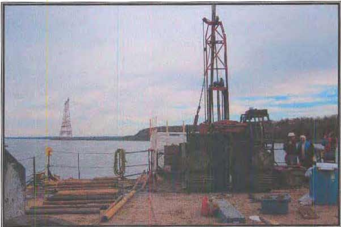
Photographie no.4: Forage F-8, 27 octobre 2004
