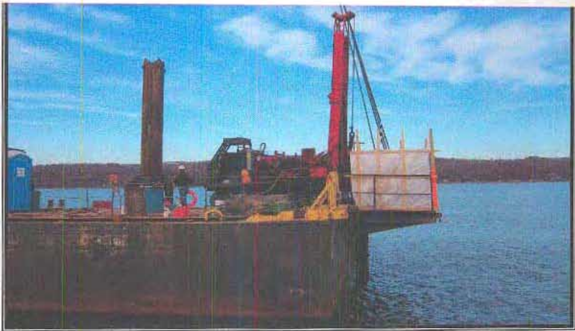
Photographie no.3: Forage F-8, 27 octobre 2004
