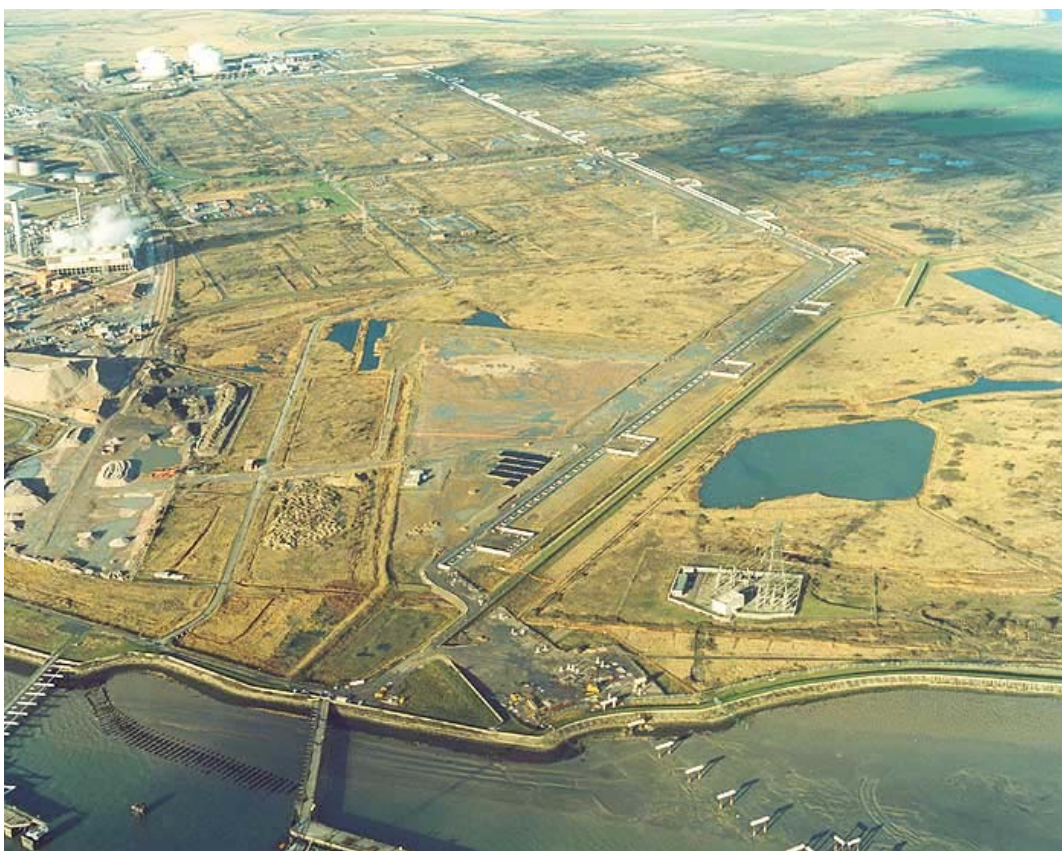
Vue aérienne de la ligne cryogénique
