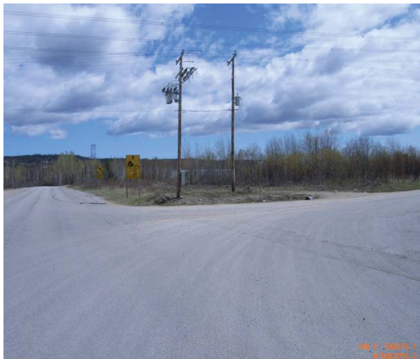
Figure 5 – Infrastructure d'Hydro-Québec à l'intersection de la route 389 et de la route de contournement
