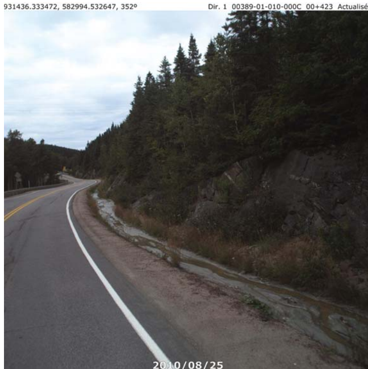
Figure 8 Faible profondeur du fossé et présence de roc (source : SIG, MTQ)
