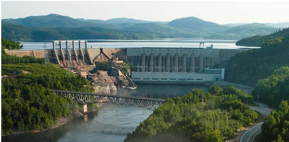
Figure 57 Photo du pont P-14682 (source : Hydro-Québec)
