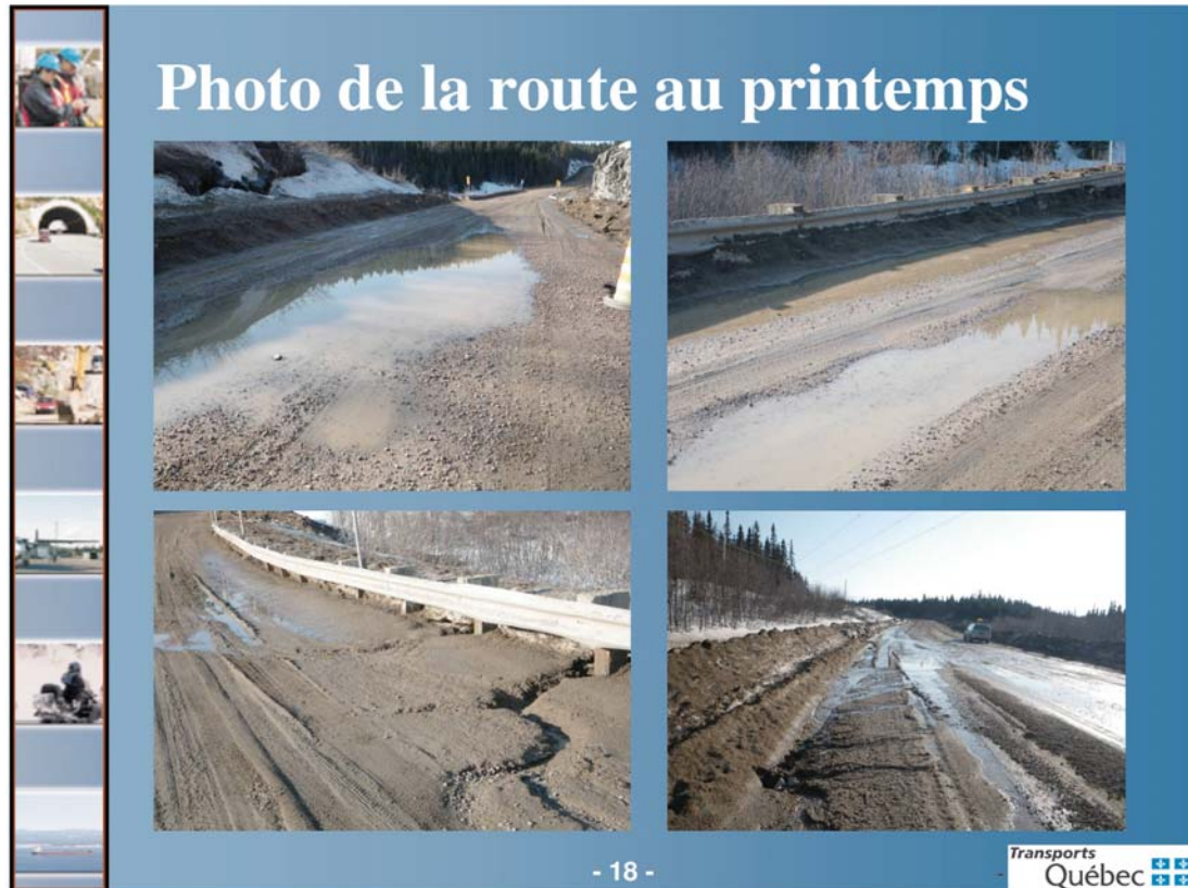
Figure 19 État de la surface de roulement de la route de contournement au printemps (extrait de la présentation PC-0 de M. Denis Lafontaine, ttp, MTQ, mai 2012)
