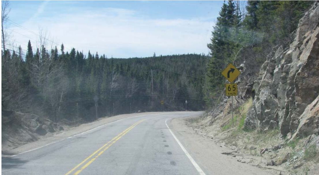
Figure 5 Proximité des surfaces de roc par rapport à la ligne de rive (Source : MTQ)
