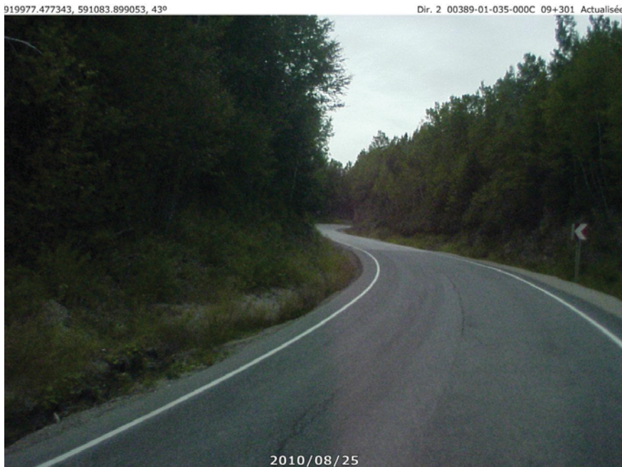
Figure 6 Faible visibilité et faible profondeur des fossés (source : SIG, MTQ)
