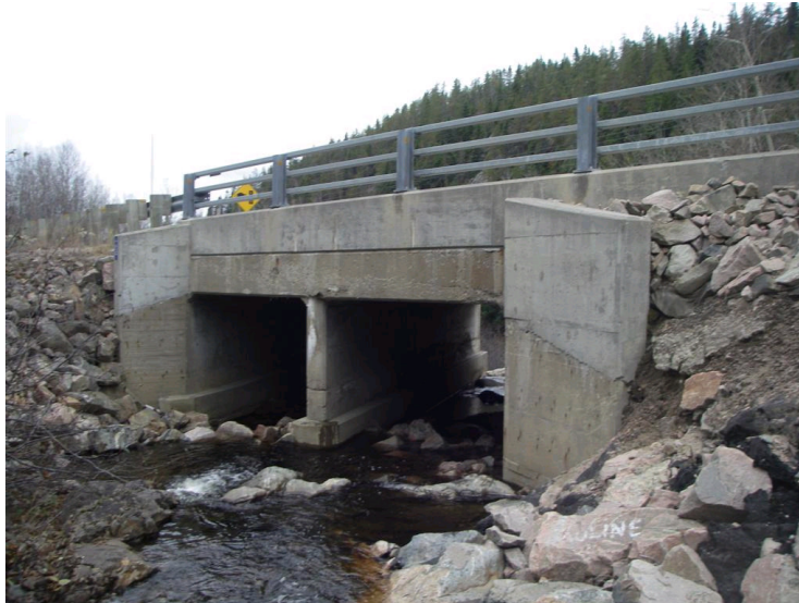
Figure 56 Photo du pont P-10248 (source : MTQ)
