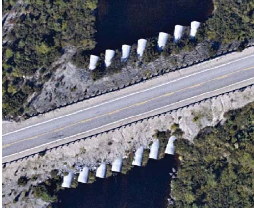
Photo 1 Pont ch. 00+050 (km 480)* (30 m)
