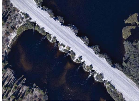
Photo 2 Pont ch. 07+430 (km 488)* (30 m)
