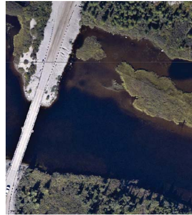
Photo 4 Pont ch. 48+300 (km 531)* (59 m)
