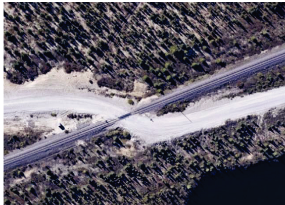
Photo 2.1 Km 489,82 : passage à niveau 4 (signalisation automatique) non conforme
