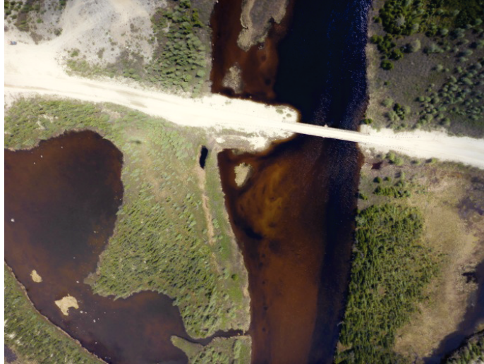
Photo 2.3 Pont P -10657 traversant la rivière aux Pékans
