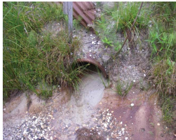
Photo 2.20 Réduction du rendement hydraulique occasionnée par la sédimentation
