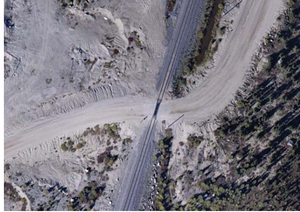
Photo 2.11 km 519,32 : passage à niveau 8 (signalisation avec panneaux d'arrêt) – Conforme
