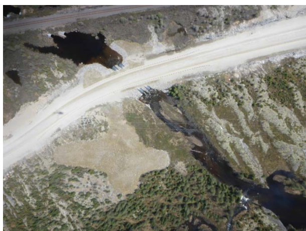
Photo 2.23 km 500 : décharge lac du Don – deux ponceaux en parallèle (Structure P-17190)
