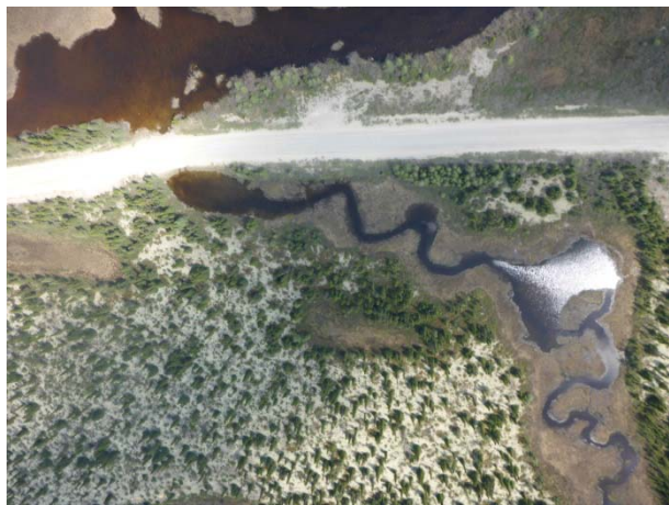
Photo 2.21 km 530 : décharge lac sans nom – deux ponceaux T.T.P. 900 mm en parallèle (P-10903 et P-90904)
