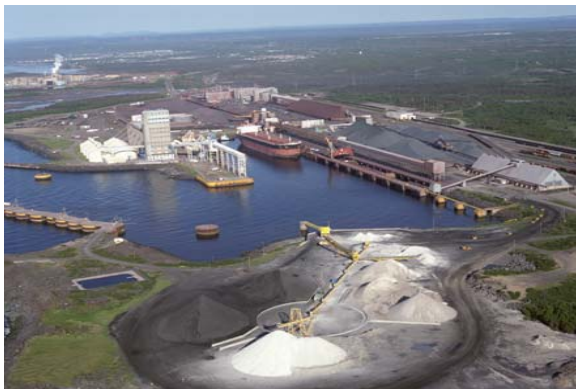
Photo 2.1 Complexe minier Port-Cartier
