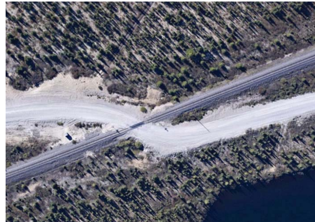
Photo 2.7 km 489,82 : passage à niveau 4 (signalisation automatique) Non conforme
