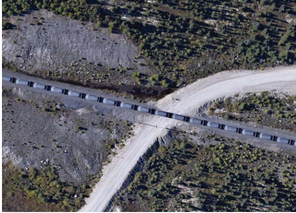
Photo 2.10 km 512,19 : passage à niveau 7 (signalisation avec panneaux d'arrêt) – Non conforme
