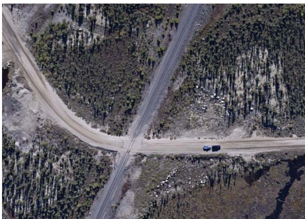
Photo 2.14 km 532,21 : passage à niveau 11 (signalisation avec panneaux d'arrêt) – Conforme
