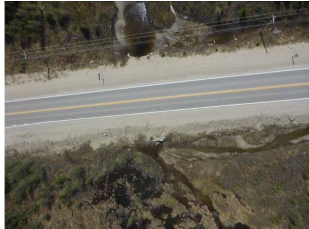
Photo 2.28 Accumulation d'eau dans le fossé longeant la route aux environs du km 564
