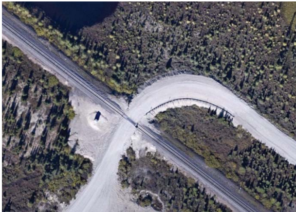
Photo 2.6 km 486,74 : passage à niveau 3 (signalisation automatique) Conforme
