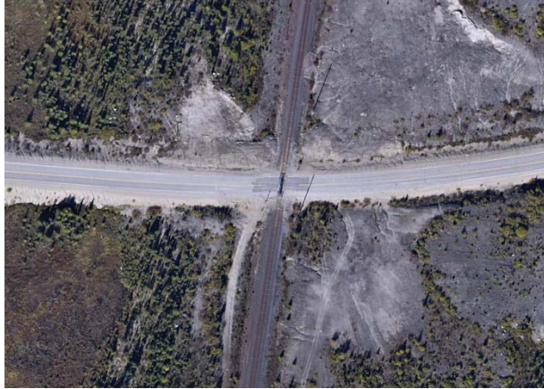
Photo 2.4 km 479,65 : passage à niveau 1 (signalisation automatique) Conforme
