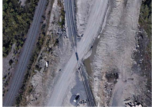
Photo 2.5 km 482,87 : passage à niveau 2 (signalisation automatique) Non conforme
