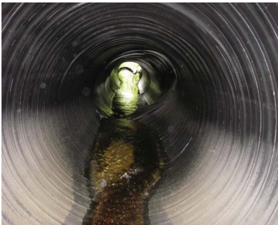
Photo 2.19 Déformation de la section transversale et mouvement affectant la capacité structurale
