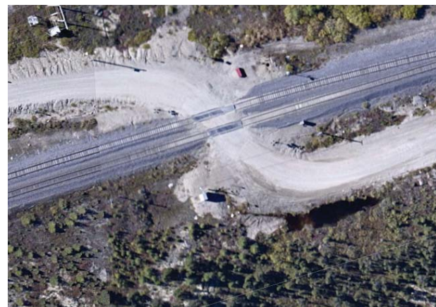
Photo 2.9 km 510,87 : passage à niveau 6 (signalisation automatique) Conforme
