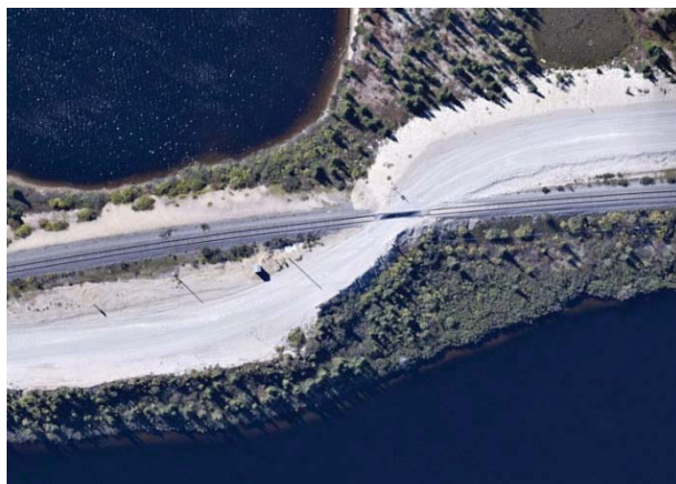
Photo 2.8 km 494,67 : passage à niveau 5 (signalisation automatique) Non conforme
