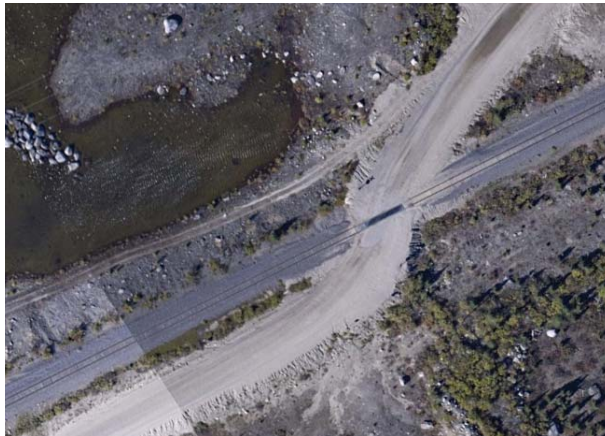
Photo 2.12 km 523,63 : passage à niveau 9 (signalisation avec panneaux d'arrêt) – Non conforme
