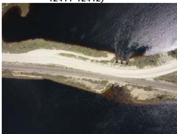
Photo 2.24 km 493 : affluent de la petite rivière Manicouagan - Trois ponceaux en parallèle (Structures P-12407-12408-12409)
