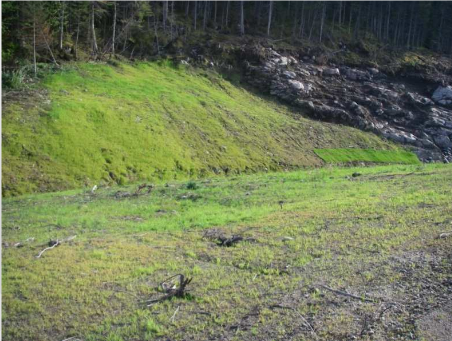
Rte-389, km 97 – travaux réalisés en 2012
