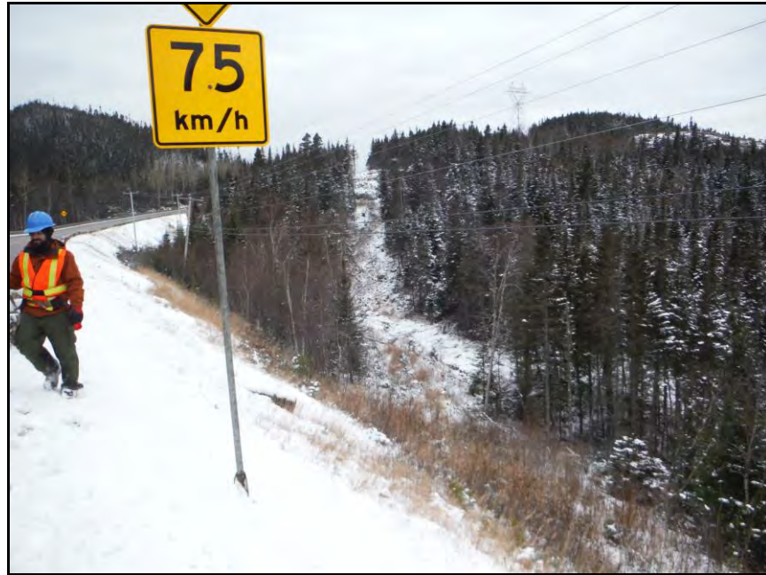
Photo 5 Vue générale du secteur 2 à la hauteur du chaînage 3+520, vers le nord-ouest (DUCD-13-0178-014)
