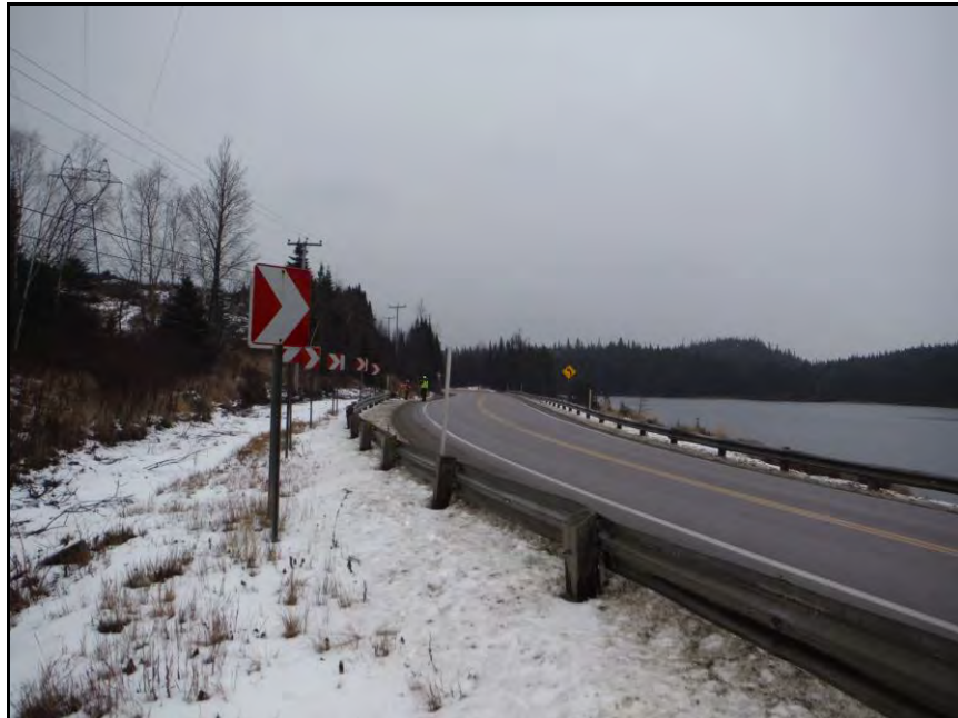
Photo 8 Vue générale du secteur 2 à la hauteur du chaînage 5+050, vers l'est (DUCD-13-0178-040)
