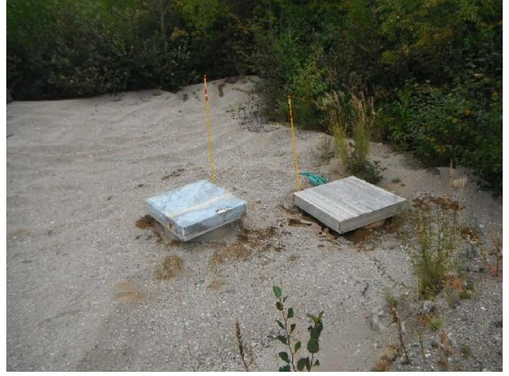
photo 22 puits de captage de l'eau souterraine
