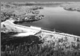
Le barrage du Portage-des-Roches
