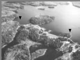
Les barrages Pibrac Est et Ouest
