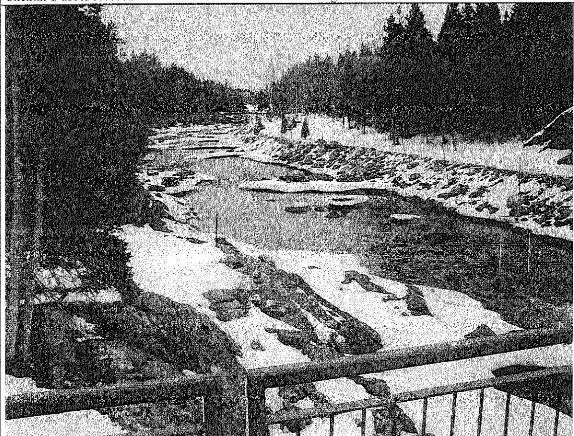
Chemin d'accès et épis construits
