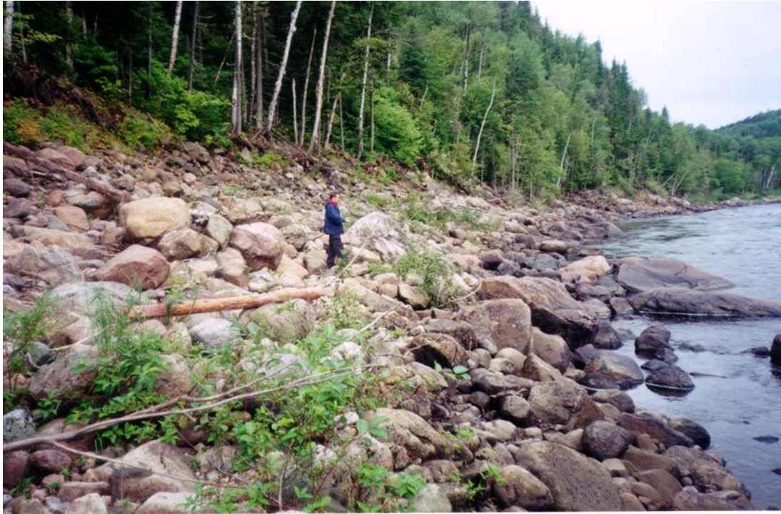
Photo 12 Rempart de blocs rehaussé lors de la crue de juillet 1996 qui constitue une protection efficace contre l'érosion, en autant que le niveau d'eau n'excède pas le niveau supérieur de la couche de matériaux résistants. Rivière Pikauba, rive gauche, km 9, vue vers l'aval.
