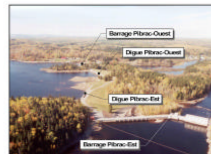
Barrages et digues Pibrac-Est et Pibrac-Ouest
