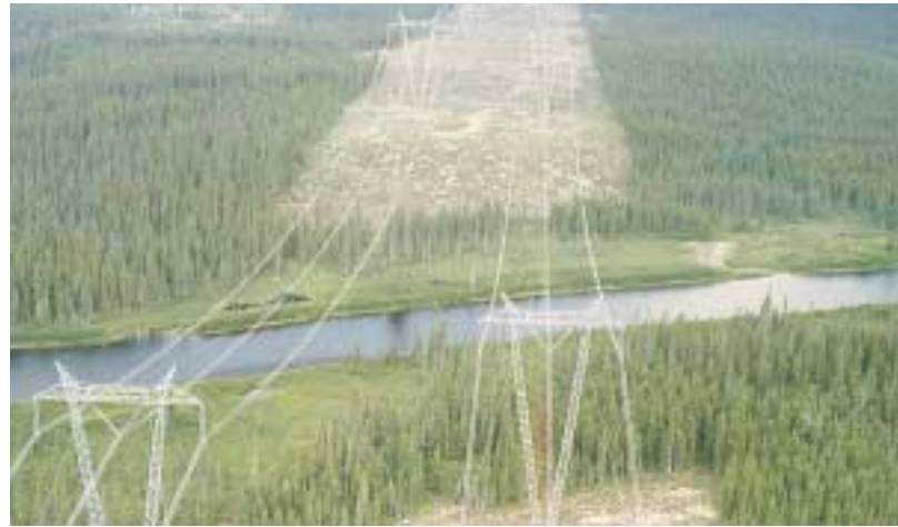
Traversée de cours d'eau par deux lignes à 735 kV. Notez la protection végétale des rives.
