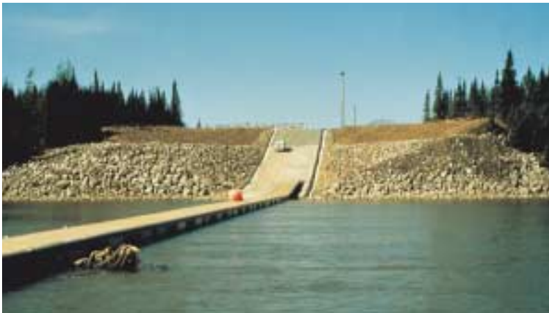
Rampe de mise à l'eau pour embarcations près de Chisasibi.
