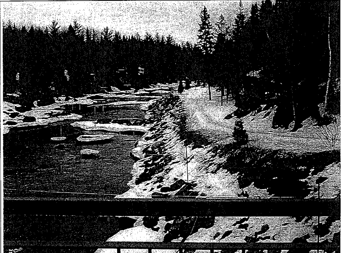
Chemin d'accès construit à même la berge du cours d'eau. (capacité d'évacuation réduite)
