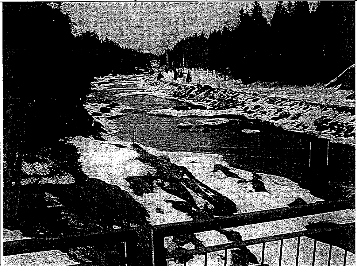
Chemin d'accès et épis reconstruits après 1996. (Prise à partir de la passerelle de CÉPAL)
