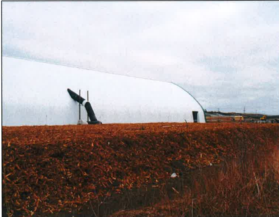
Un biofiltre assure le traitement de l'air.
