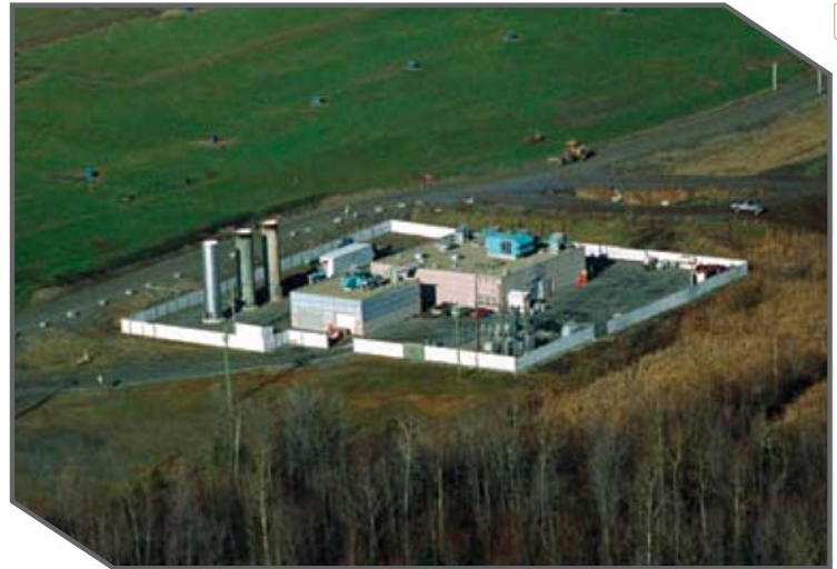
La centrale électrique reçoit les biogaz captés sur le site, produisant de ce fait quatre mégawatts d'électricité annuellement.
