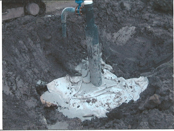
Pose de géocomposite au puits 353A
