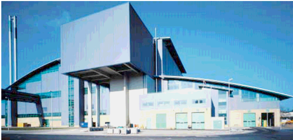
Figure 7-4-1 Exemple d'une installation d'incinération de AE&E Von Roll à Nuremberg en Allemagne
