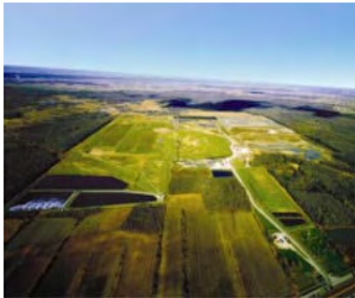
Figure 7-6-1 Vue aérienne du site d'enfouissement à Lachenaie, Qc
