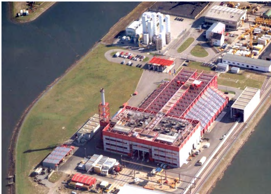
Figure 7-5-1 Vue aérienne de l'usine de gazéification de Thermosteel implantée à Karlsruhe en Allemagne
