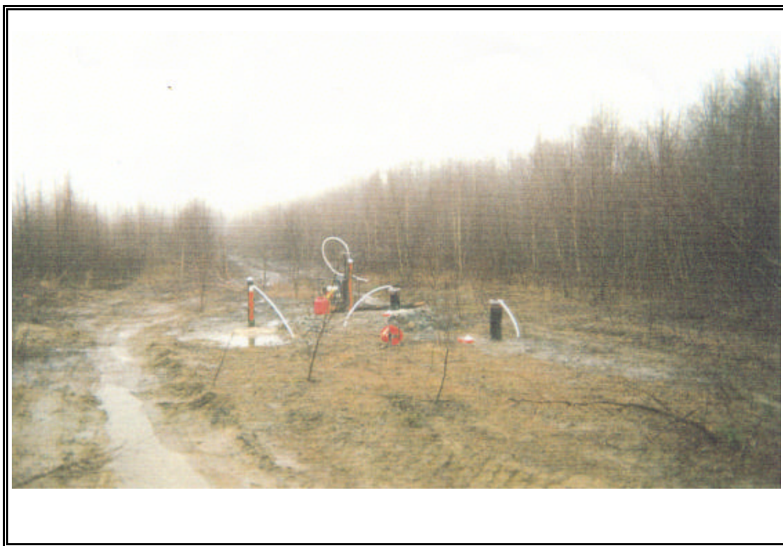
PHOTO 9 : Développement des puits d'observation au site de forage S-12. Vue vers le sud.
