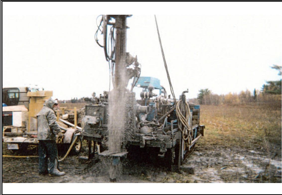
PHOTO 3 : Réalisation d'un forage au site S-9 à l'aide du marteau fond de trou (rotation-percussion). Vue vers le nord.
