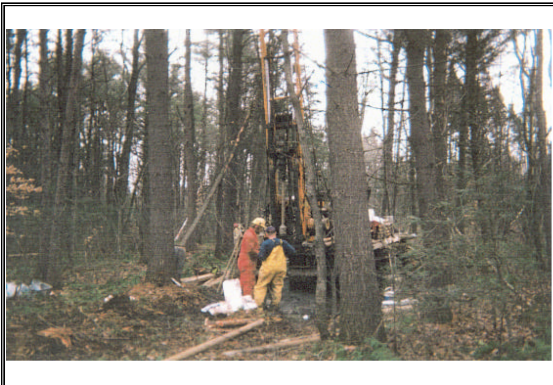
PHOTO 4 : Réalisation d'un forage au site S-25. Vue vers l'est.
