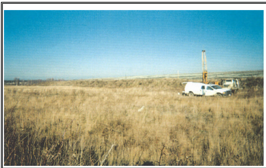
PHOTO 1 : Réalisation du forage au site S-6. Vue vers le nord.
