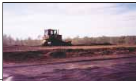
Aménagement du toit du bioréacteur par la mise en place d'une couche de protection de la membrane.
