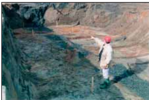
Mise en place d'un écran d'étanchéité appelé mur de bentonite.
