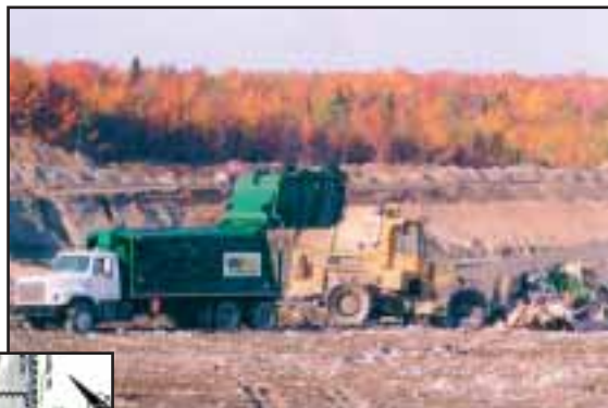
Déchargement des matières et compaction au front des opérations.
