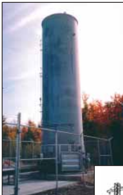
Deux torchères comme celle-ci sont en opération à Sainte-Sophie. Une troisième sera aménagée lors de l'exploitation du futur bioréacteur.
