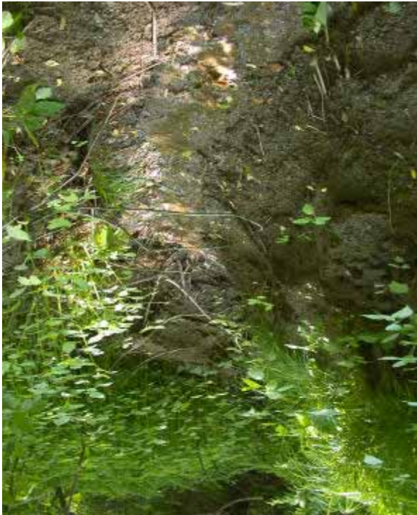
Photo 6 Affluent du ruisseau - fossé de drainage agricole. Projet 03-1009
