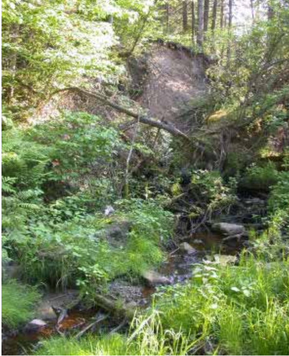
Photo 5 Zone de glissement de terrain. Lit du ruisseau encombré de débris et de blocs.
