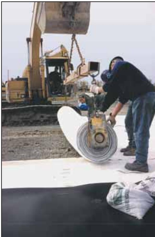
Mise en place de la natte bentonitique imperméable.
