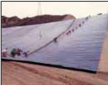
Mise en place d'une membrane d'imperméabilisation sur une paroi de cellule.
