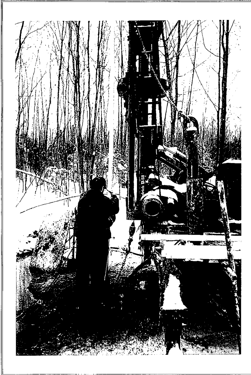
Photo N°7 Mise en place du piézomètre au forage F00-10
