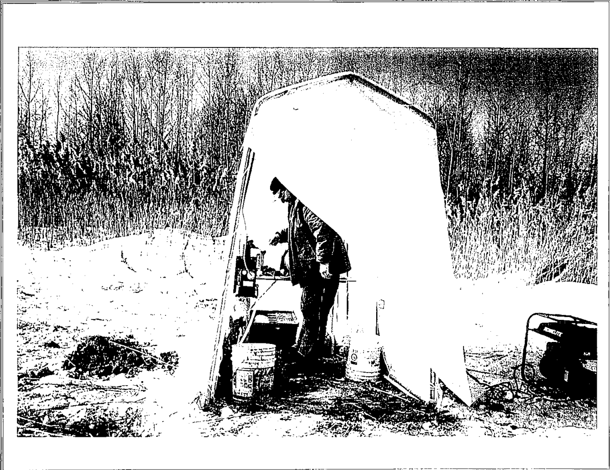
Photo #8 Développement du puits F00-7
