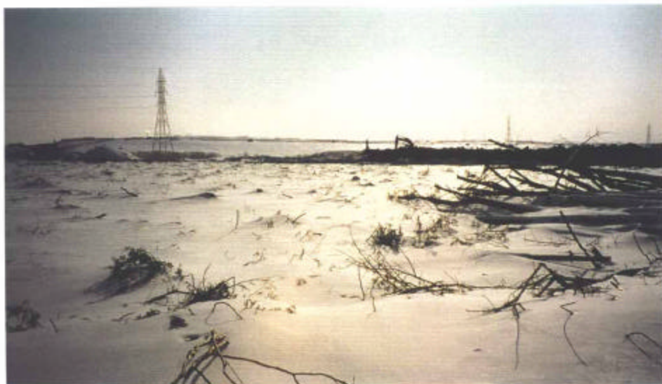
PHOTO 5: SECTEUR NORD DU SITE EXISTANT TRAVAUX EN COURS. ONT- ILS EU L'APPROBATION?
