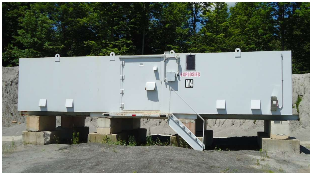
Figure 7 – Photo d'une poudrière préfabriquée typique
