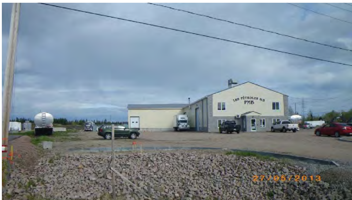
Photo 3 : Vue vers l'est. Entreposage et/ou équipement de distribution d'hydrocarbures et activité désignées à l'Annexe III du RPRT (Les Pétroles MB)
