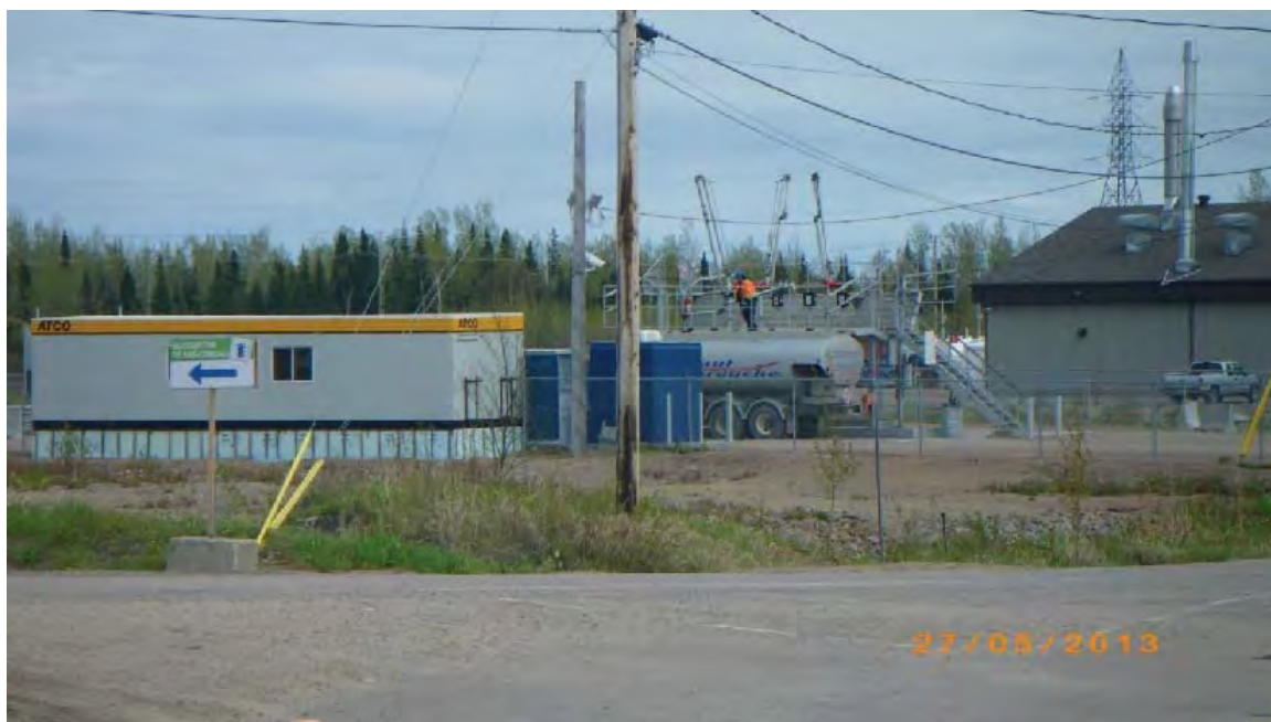
Photo 1 : Vue vers l'est. Entreposage et/ou équipement de distribution d'hydrocarbures et activité désignées à l'Annexe III du RPRT (Distribution Nord)
