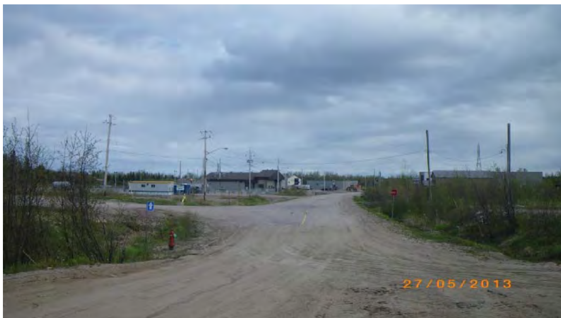
Photo 2 : Vue vers l'est. Entreposage et/ou équipement de distribution d'hydrocarbures et activité désignées à l'Annexe III du RPRT (Distribution Nord)
