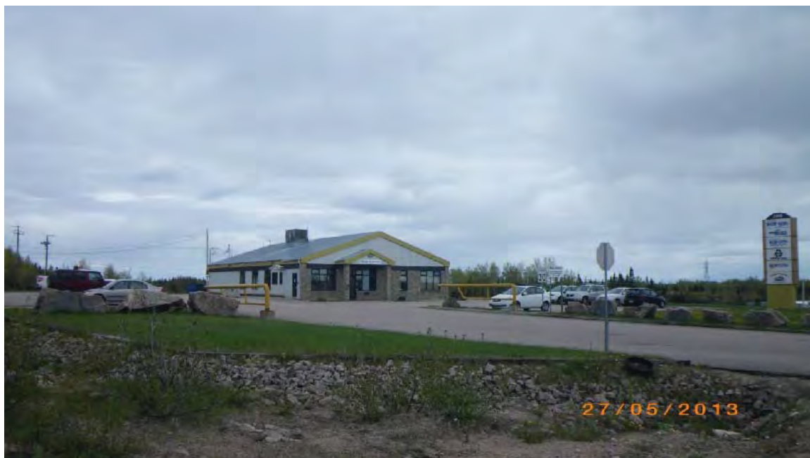
Photo 4 : Vue vers l'est. Entreposage et/ou équipement de distribution d'hydrocarbures (Les Carrières Bob-Son)
