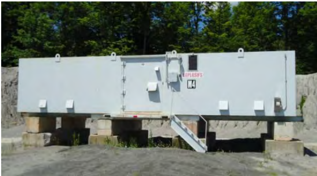
Figure 5-6 : Photo d'une poudrière préfabriquée typique
