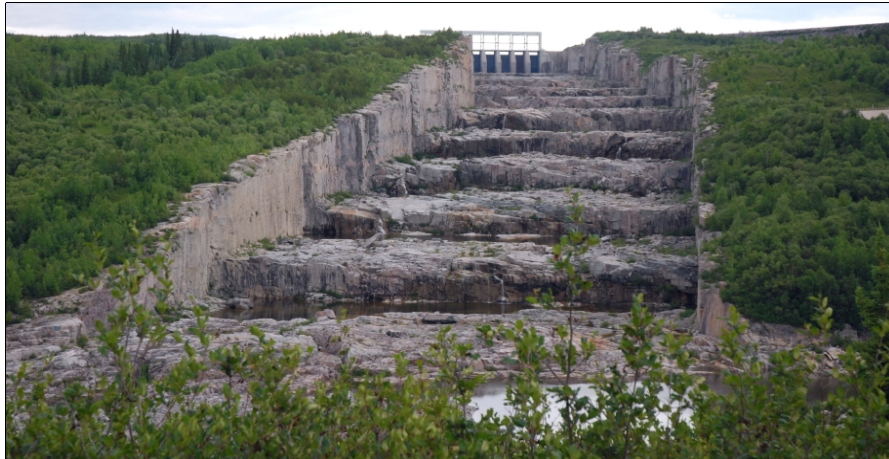
La Grande, Baie-James, 2008-juillet-15. L'évacuateur.
