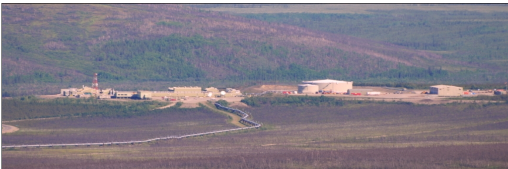
Station de pompage numéro 5, Alaska, 2009-juin-23. Le pipeline de 48 pouces de diamètre qui achemine le pétrole de Prudhoe Bay jusqu'à Valdez.
