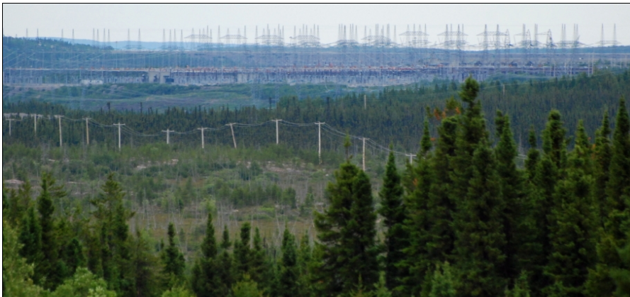
La Grande, Baie-James, 2008-juillet-15. Pylônes et fils au nord.
