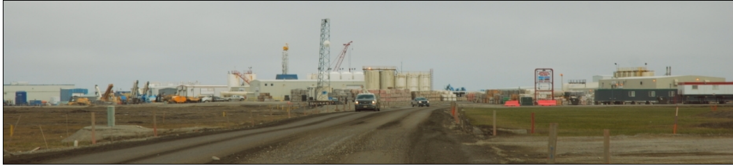
Deadhorse, Prudhoe Bay, Alaska, 2009-juin-24. Une localité construite par l'industrie pétrolière seulement pour l'industrie pétrolière.
