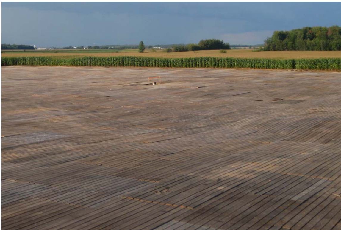
FIGURE 3.2 PLATEFORME AVEC MATELAS DE CHÊNE
