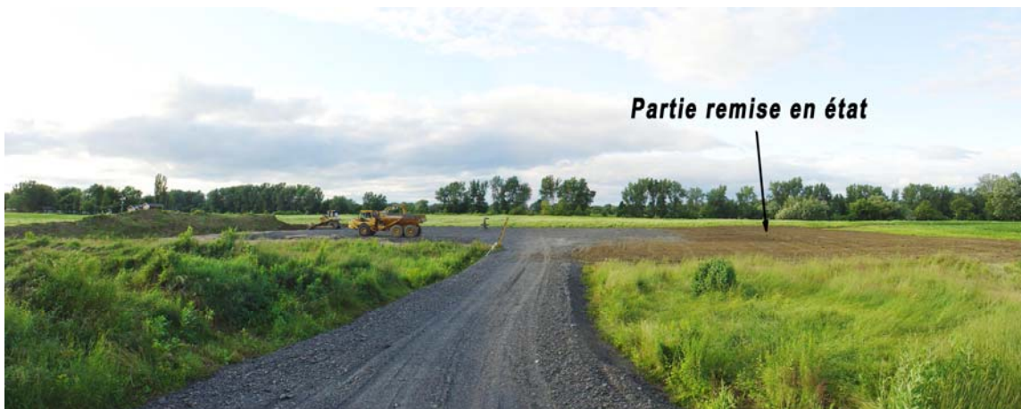
FIGURE 3.4 SITE DURANT UNE REMISE EN ÉTAT
