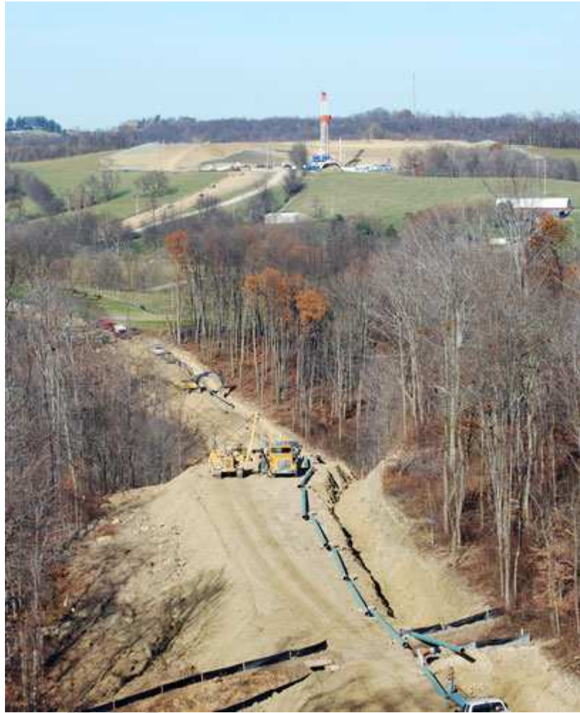
Figure 14 - Construction d'un gazoduc, Amwell, comté de Washington, Pennsylvanie
