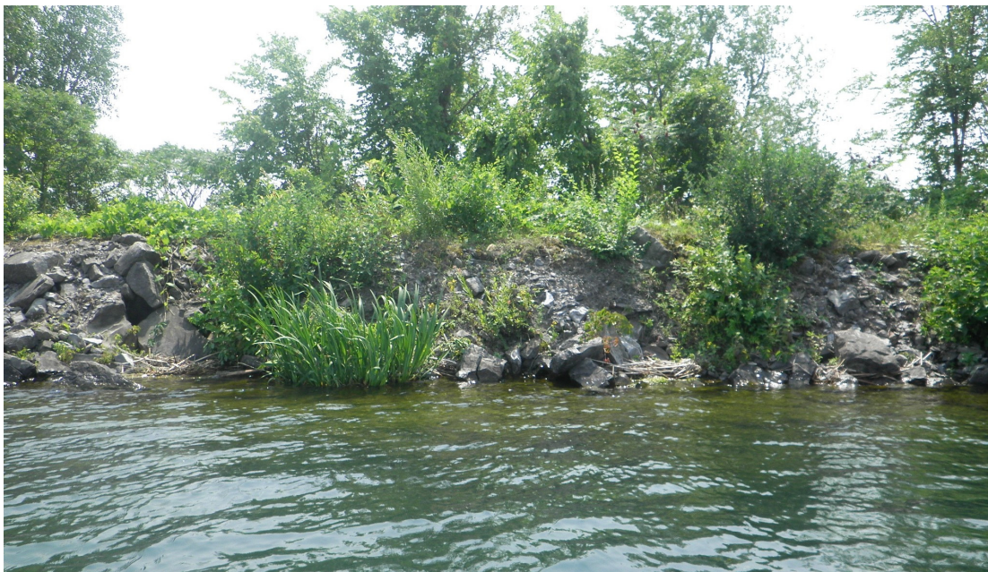
Photo QC-20-2 : Enrochement sur la rive nord du remblai amont de la digue (canal d'amenée)
