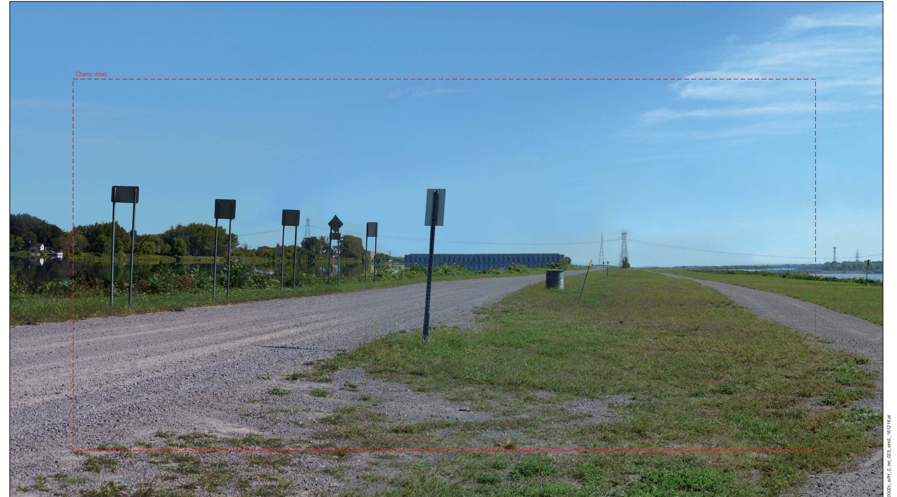
Vue de la digue vers la centrale des Cèdres (direction est)
