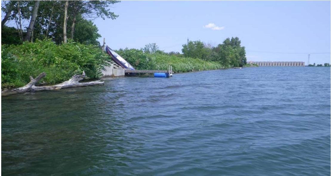
Photo 4-2 : Enrochement végétalisé sur la rive nord du canal d'amenée – Vue vers la centrale des Cèdres en aval
