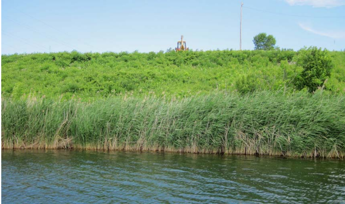
Photo 4-10 : Berge de remblai et d'enrochement végétalisé dans le bassin de la Pointe-du-Buisson
