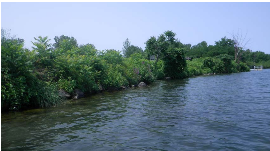
Photo 4-4 : Enrochement bien végétalisé sur la rive sud du canal d'amenée
