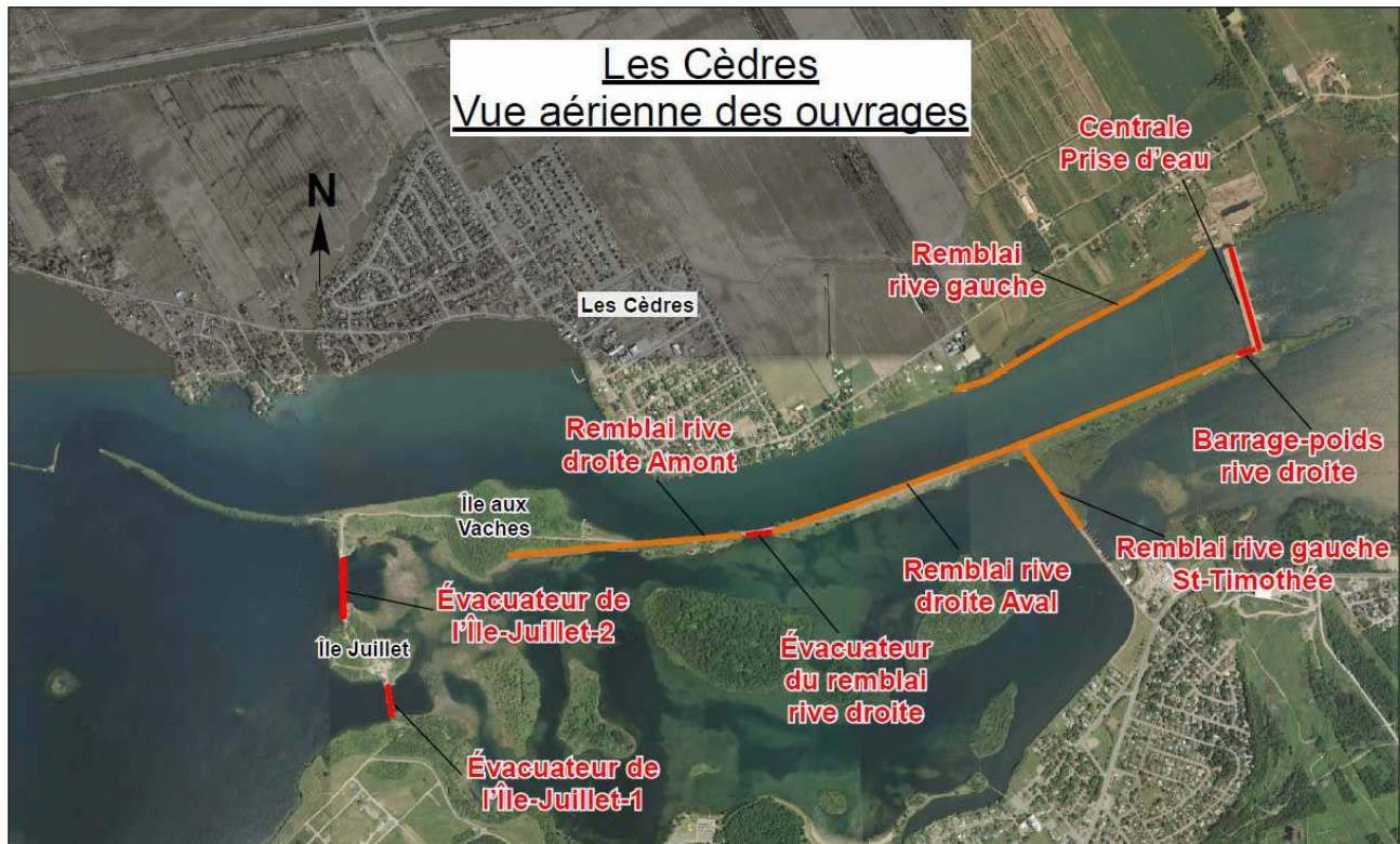
Figure 1 Emplacement du remblai rive droite de la centrale Des Cèdres
