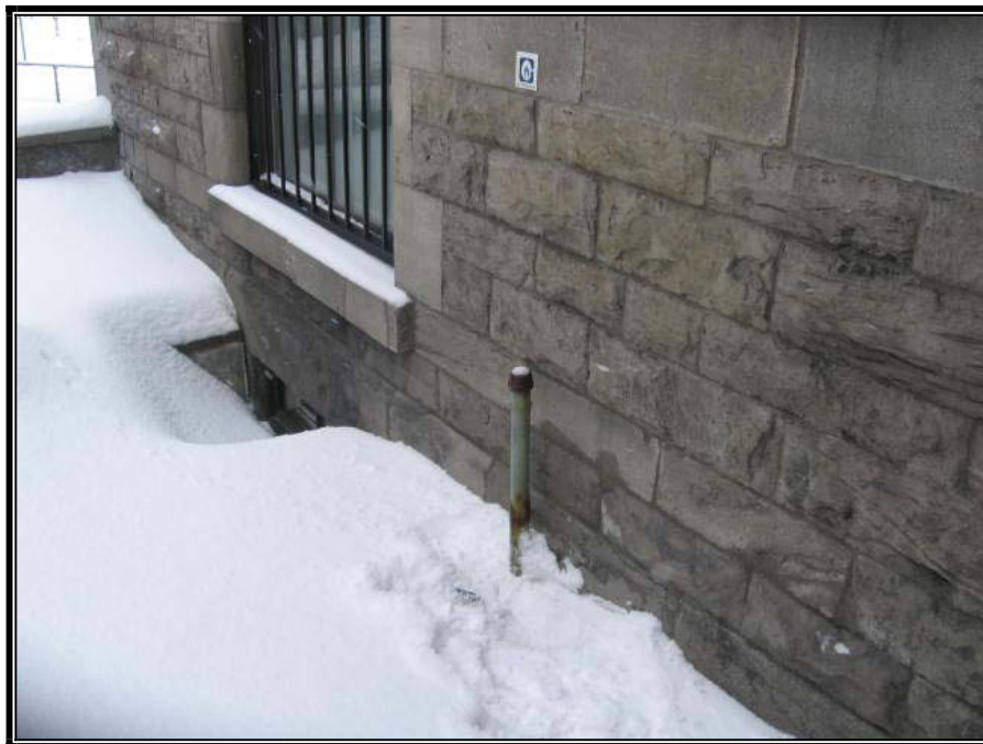
Photo n° 10 : Tuyau d'alimentation observé au 178-182 et 184-188, rue Selby
