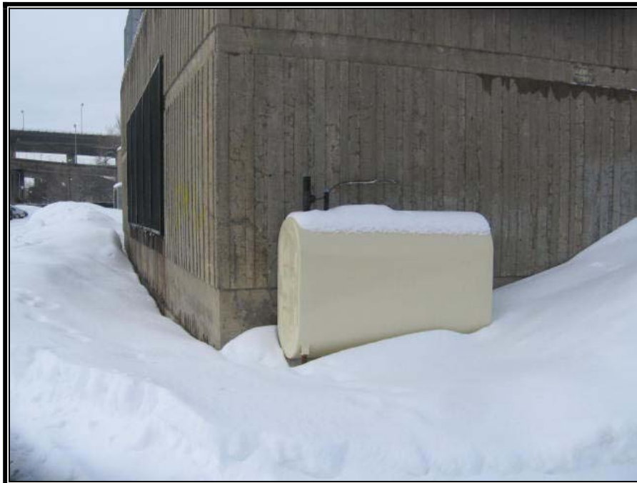
Photo n° 38 : Réservoir hors sol présent au 5440, rue Notre-Dame O
