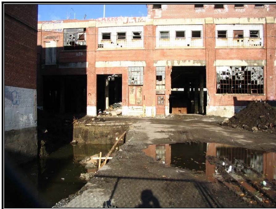
Photo n° 7 : 4107, rue de Richelieu. À gauche, des monticules de matériaux hétérogènes
