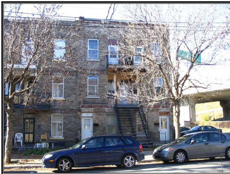
Photo n° 3 : 818-828 et 830-840, rue Desnoyers
