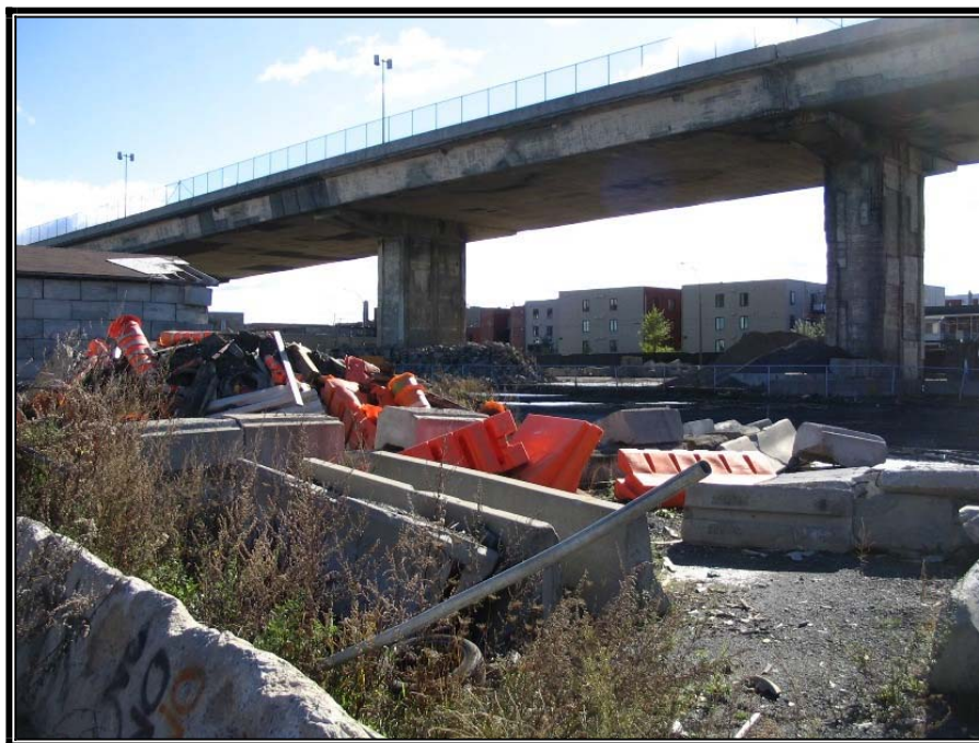
Photo n° 18 : Section de la rue Hadley à la rue Eadie (lot 1 573 593)
