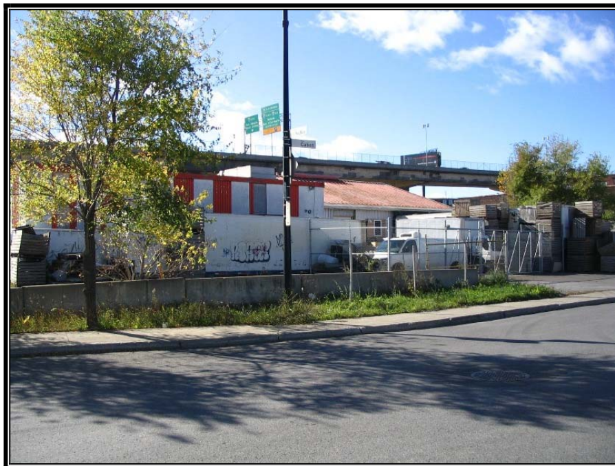
Photo n° 19 : Section de la rue Hadley à la rue Eadie (2050, rue Cabot)
