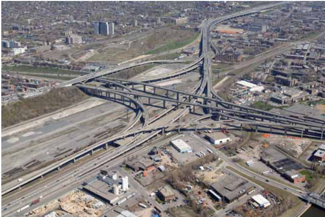
Vue générale de l'échangeur Turcot avant la réalisation du projet
