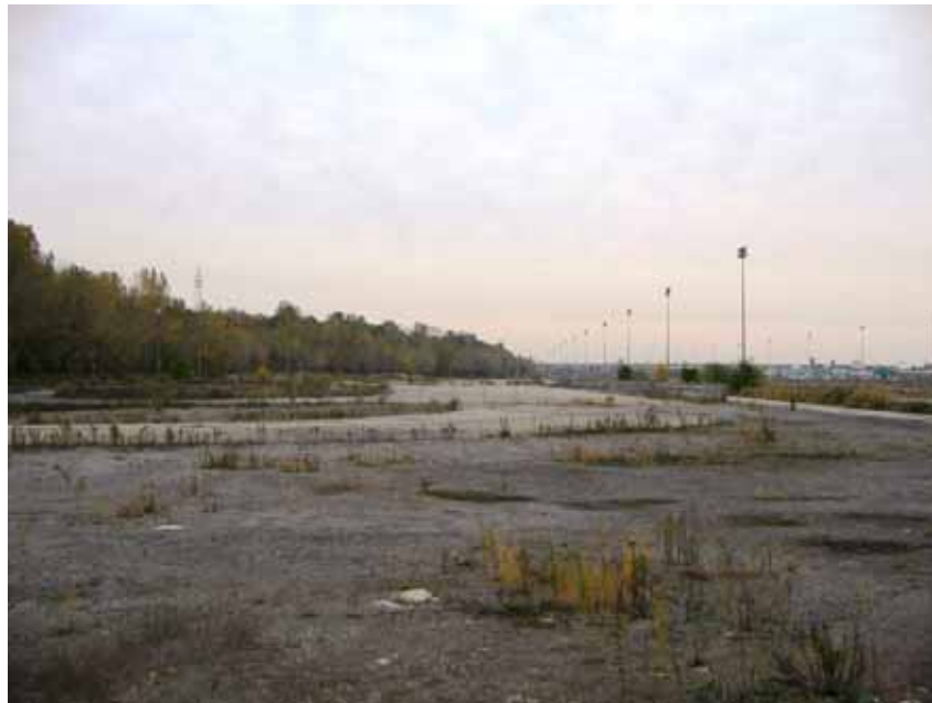
Vue avant de l'autoroute 20 et des voies du CN
