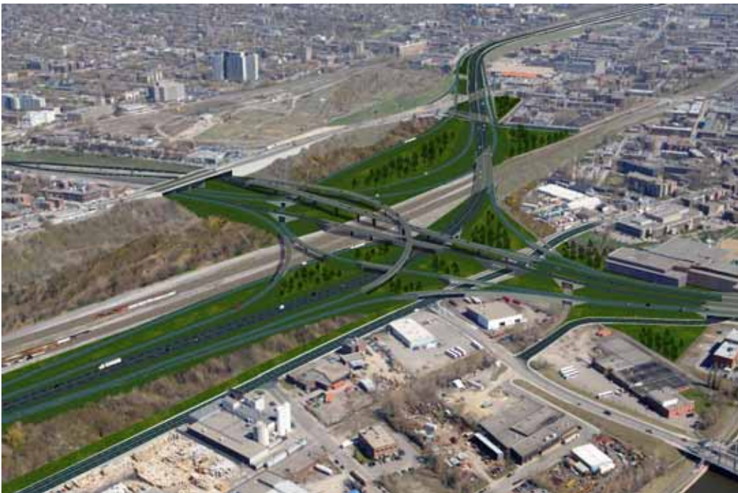
Vue générale de l'échangeur Turcot après la réalisation du projet
