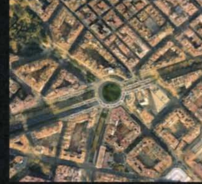
CONNEXION ANCIEN BOUL. ET NOUVEAU BOUL. centre ville
