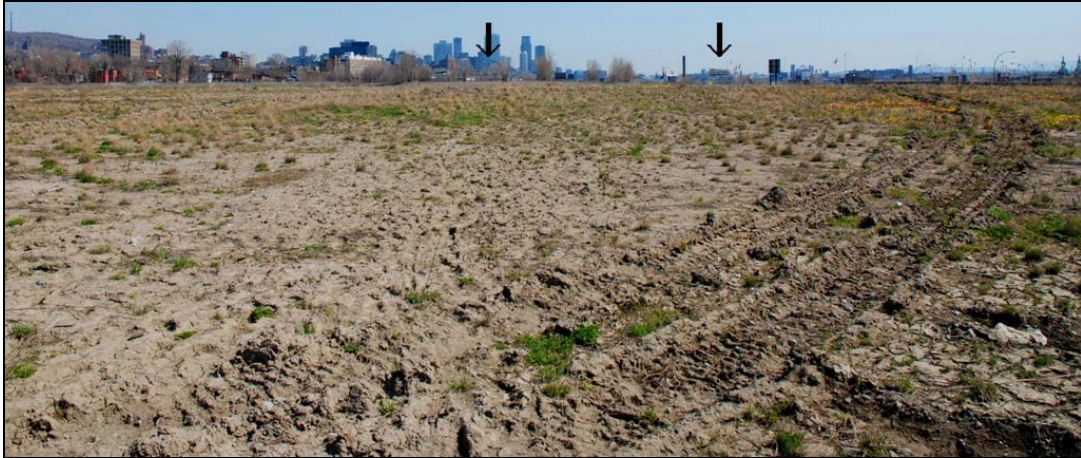
Terrain CUSM, 2009-avril-25 : Une immense zone de travail. Les flèches pointent sur deux groupes de panneaux signalétiques de l'autoroute 720.
