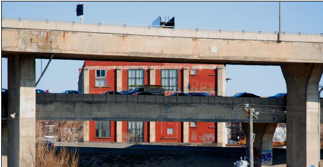
Rue Saint-Rémi, 2009-avril-24 : Logis où autoroute?
