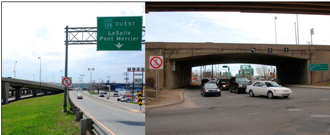
Pont Mercier, 2009-avril-25, Trottoir Est de l'avenue Saint-Pierre, 2009-avril-25 : Interdits aux piétons.
