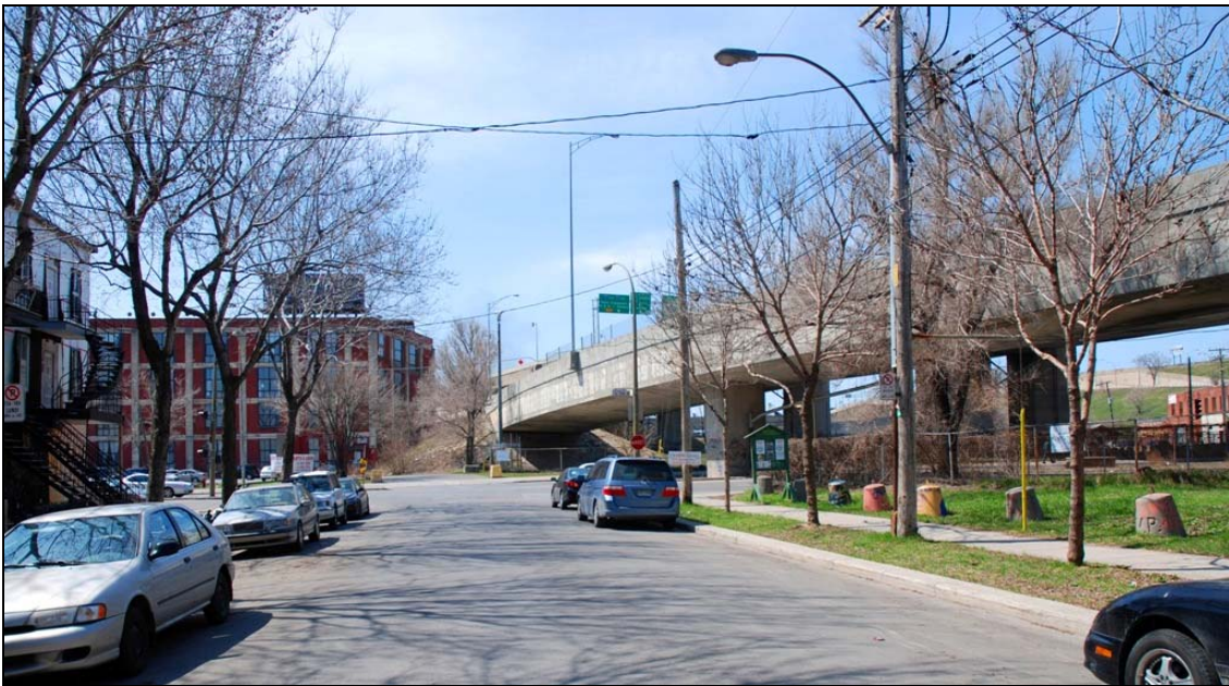
Rue Saint-Rémi, 2009-avril-24 : Un milieu de vie à protéger.
