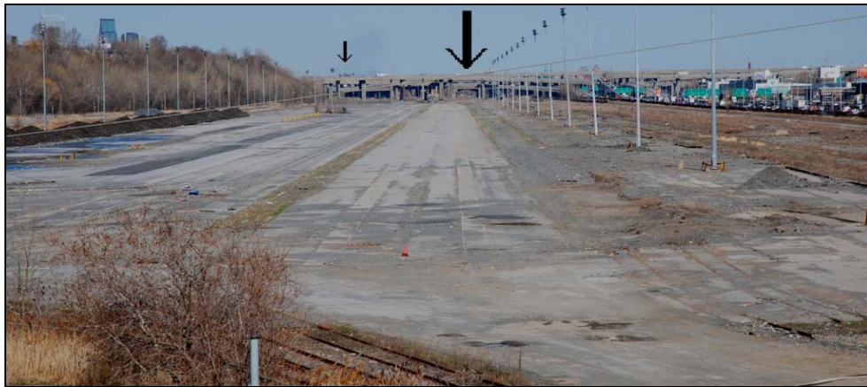
Ancienne gare de triage, 2009-avril-24 : La petite flèche pointe sur le deuxième groupe de panneaux. La grosse flèche pointe sur une grande arche où peut passer une autoroute temporaire. La photo a été prise à partir du viaduc Angrignon.
