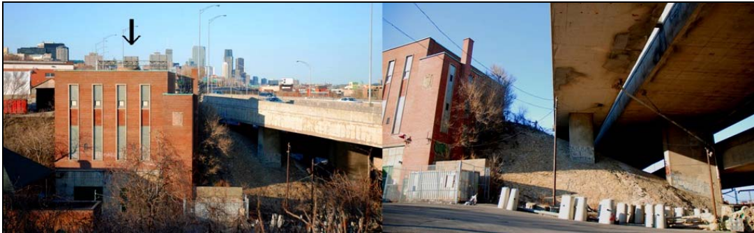
Poste Glen, 2009-avril-24 : Une utilité publique contournée. La flèche pointe sur le premier groupe de panneaux signalétiques de l'autoroute 720.
