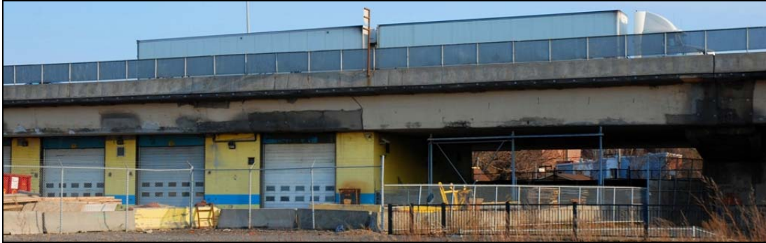
Rue Cabot, 2009-avril-25 : Garages et zone d'entreposage. Il faut bien entendu prévoir des structures qui ne laissent pas passer les coulis de sel et ne se désagrègent pas avec le temps.
