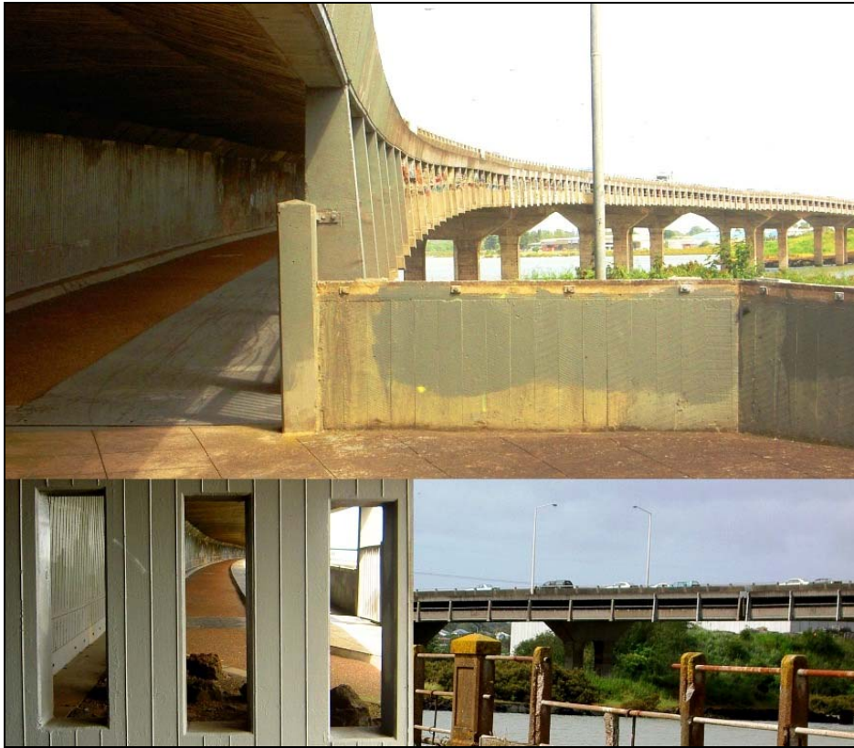
South Western Motorway, Manukau Harbour, Auckland, NZ, 2004-décembre-03 : Une piste cyclable sous le tablier d'un pont autoroutier.
