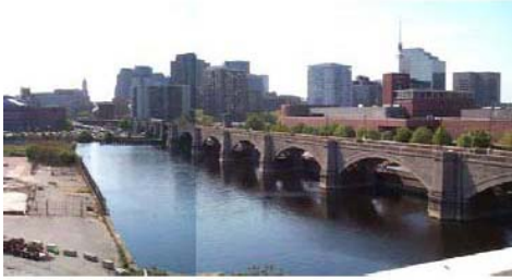
Figure 3.13 État actuel de la rive
