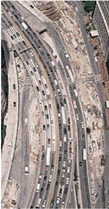
Figure 3.3 Photographie aérienne de l'autoroute avant sa démolition
