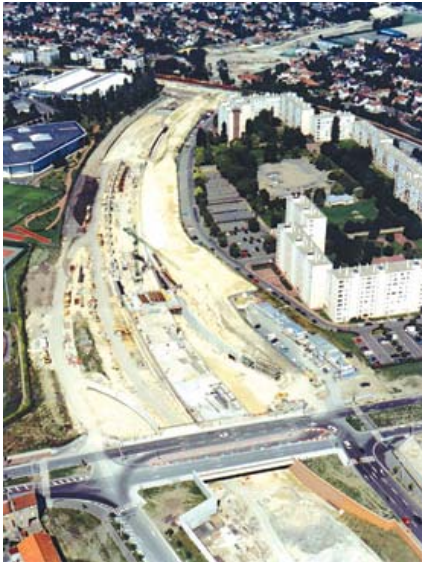
Figure 7.14 Emplacement de la semi-couverture dans le quartier des Marais à Saint-Gratien
