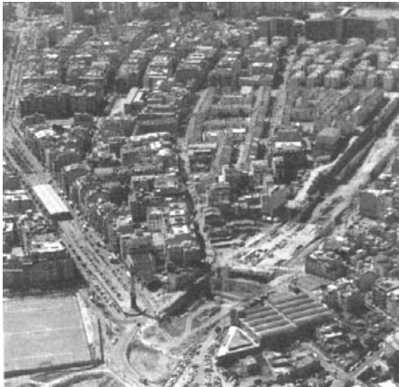
Figure 2.10 La Ronda de la montagne Une attention particulière a été portée à l'insertion de la voie dans l'espace laissé vide entre les constructions riveraines.
