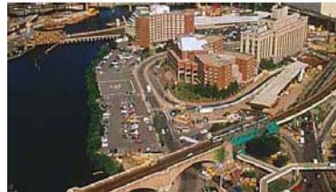
Figure 3.4 Vue entre le centre-ville et Charlestown (avant la démolition)
