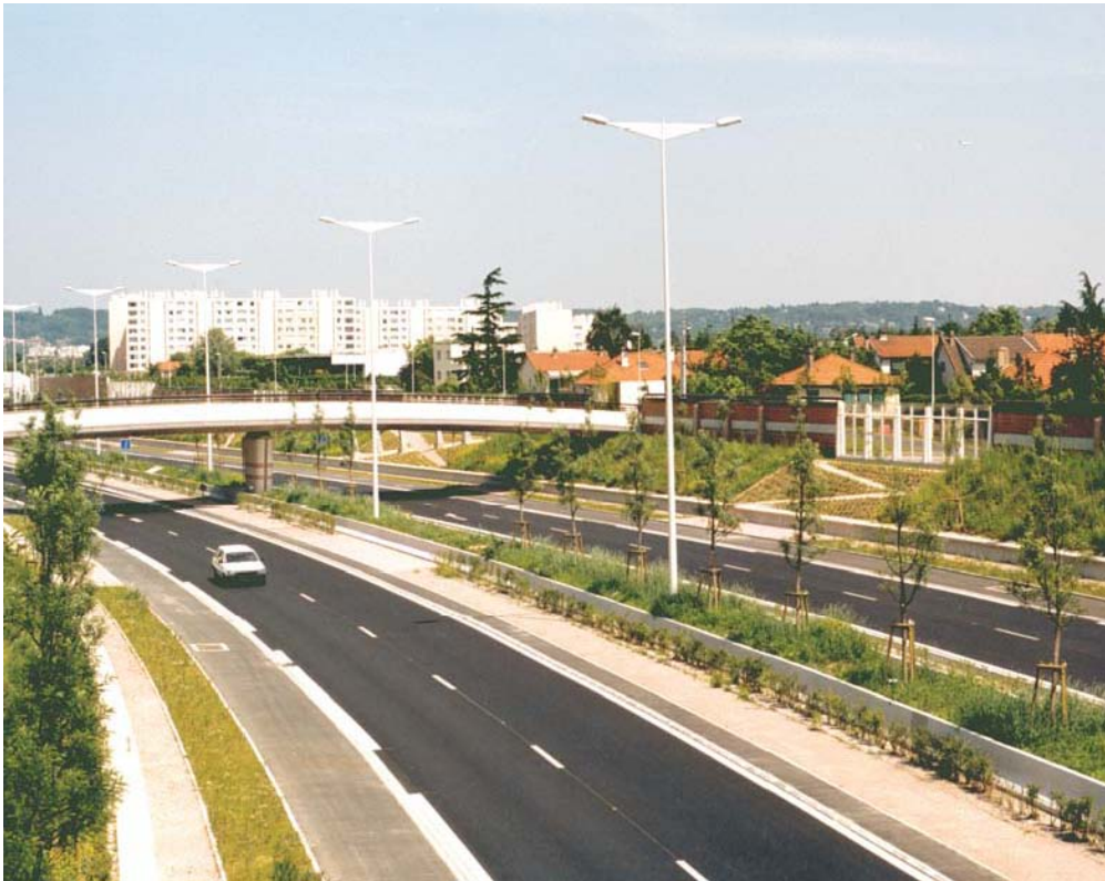
Figure 7.4 Photographie d'ensemble du boulevard
