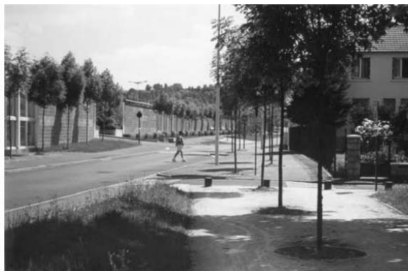
Figures 7.5, 7.6, 7.7, 7.8 et 7.9 Interface de l'autoroute et son milieu d'insertion
