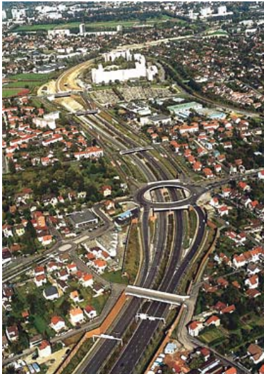
Figure 7.3 Photographie aérienne du boulevard Segment situé au croisement de la RD 14
