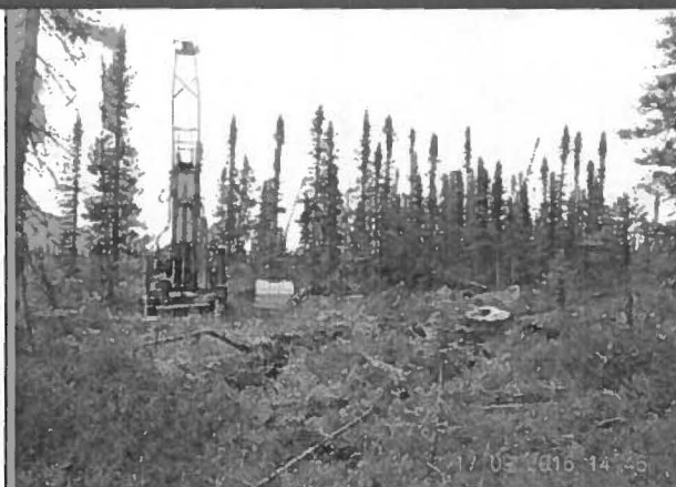
Note : Digue B+ Installation de la foreuse sur TF-16-02. Vue ver le Nord.
