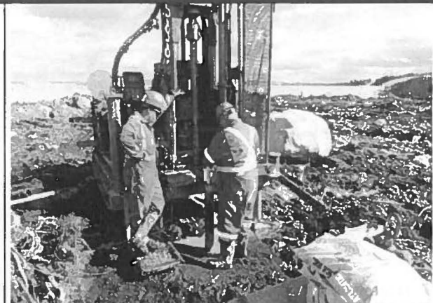
Note : Forage TF-16-58 Installation d'un puit d'observation Vue ver la Sud
