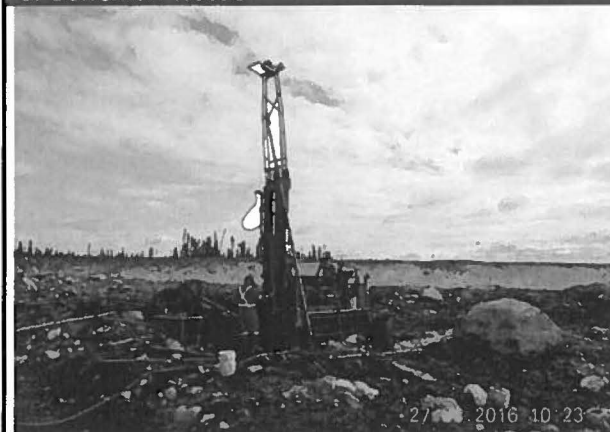
Note : Digue Hessé 4 Forage TF-16-58 Vue ver l'Est
