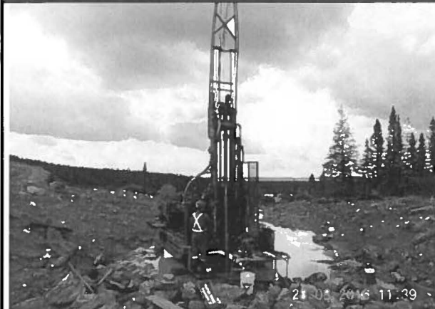
Note : Digue Hessé 4 Forage TF-16-59. Vue ver l'Ouest
