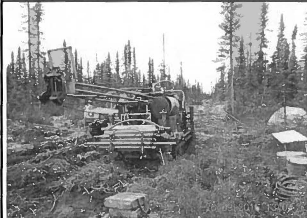
Note : Hessé 4 Déplacement de la foreuse sur TF-16-55. Vue ver le Nord.
