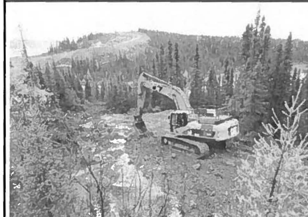
Note : Hessé 4 Construction de la pad d'assise. Vue ver le Sud.
