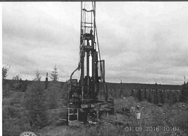
Note : Digue B+ Forage TF-16-10, Installation. Vue ver l'Est
