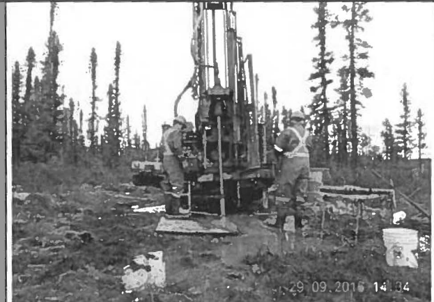
Note : Hessé 4 TF-16-53 installation de foreuse. Vue ver le Nord-Est.
