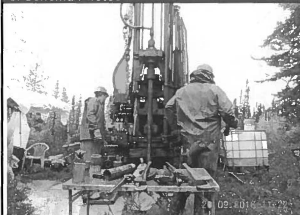
Note : Digue B+ Forage TF-16-03. Vue vers l'Ouest
