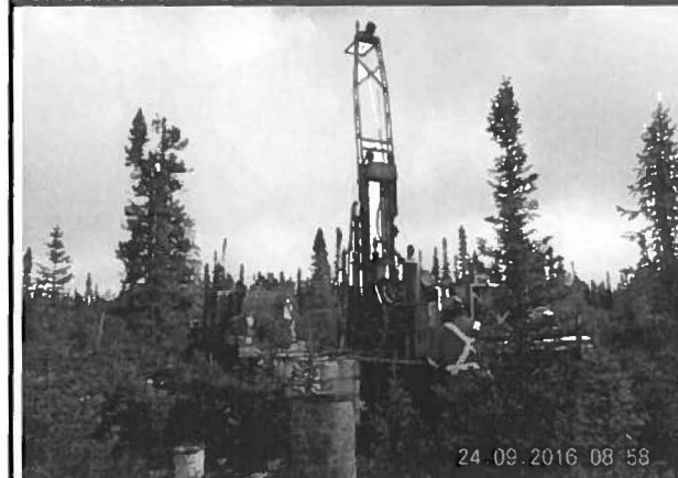
Note : Digue B+ Forage TF-16-05. Vue ver l'Est
