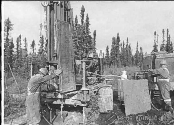
Note : Digue B+ Installation d'un puit d'observation dans le roc sur TF-16-01. Vue ver le Nord.
