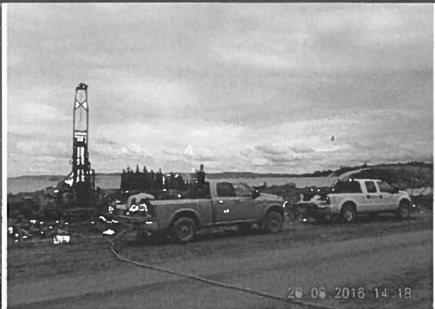
Note : Forage TF-16-58 Vue ver la Sud
