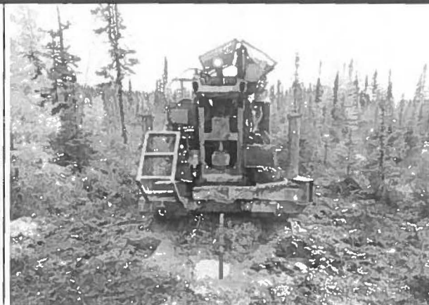
Note : Digue B+ Démobilise de TF-16-05. Vue ver l'Est
