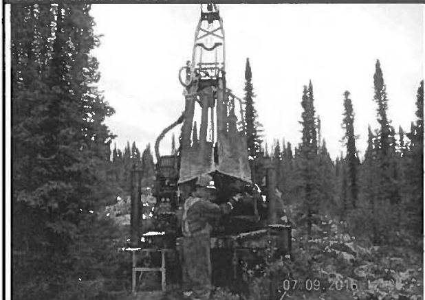
Note : Digue B+ démoblisse foreuse. Vue ver la Sud.
