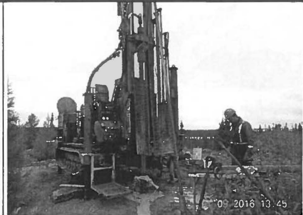
Note : Digue B+ Forage TF-16-10. Vue ver l'Est
