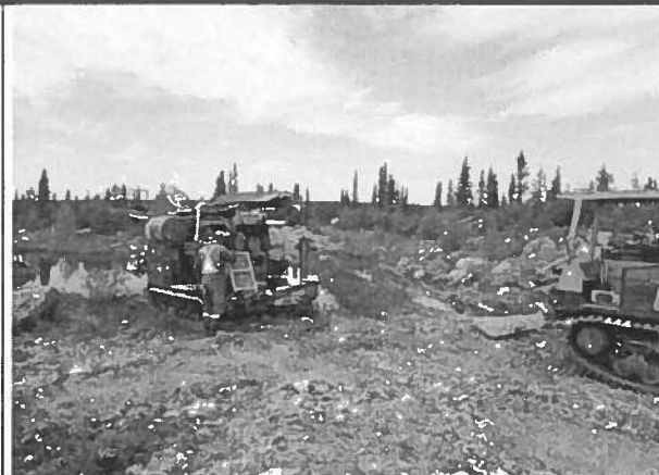
Note : Digue B+ Forage TF-16-09 Installation du foreuse. Vue ver la Nord.
