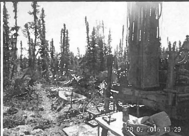
Note : Hessé 4 TF-16-54 installation de foreuse. Vue ver le Sud.
