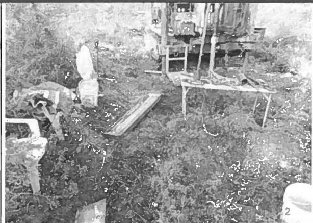
Note : Digue B+ Forage TF-16-11. Vue ver la Nord.
