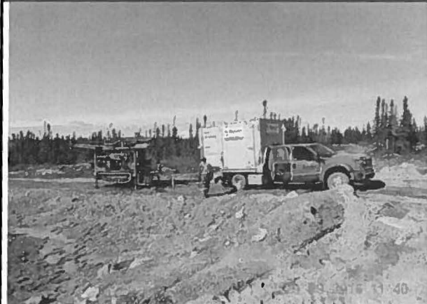
Note : Hessé 4 Réparation du foreuse. Vue ver le Nord.
