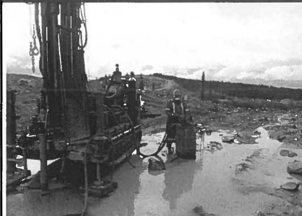
Note : Digue Hessé 4 Forage TF-16-59, brassage et injection du coulis. Vue ver l'Ouest
