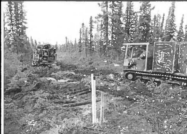
Note : Digue B+ Forage TF-16-11, Installation complétée, déplace ver TF-16-09. Vue ver la Nord.
