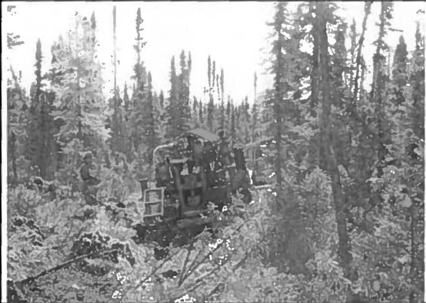
Note : Hessé 4 Déplacement de la foreuse Vers TF-16-54. Vue ver le Sud.
