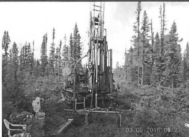
Note : Digue B+ Forage TF-16-11, Forage de roc. Vue ver la Nord.
